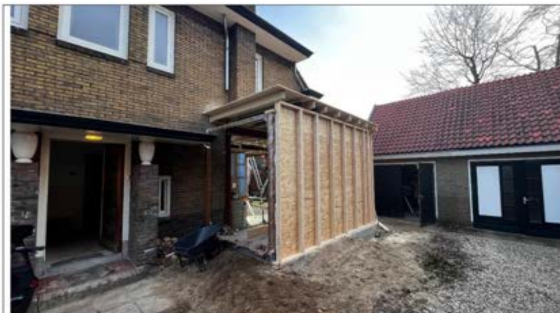
Uitbouw gezien vanaf de openbare weg/oprit (foto: 25/01/24)
