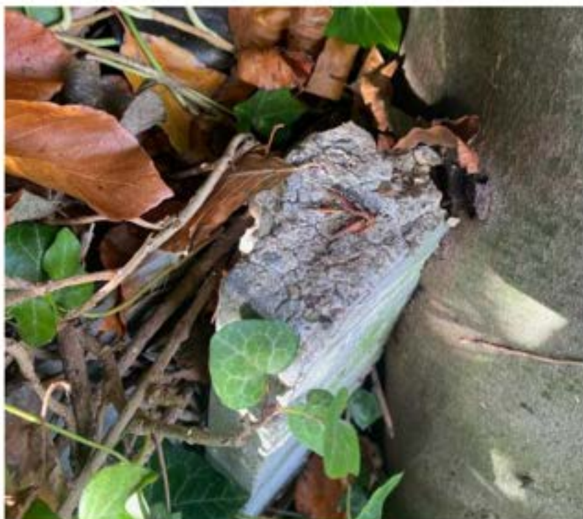
De gebroken pilaar aan de rechterkant (vanuit Kwant gezien) van de constructie/keerwand.
