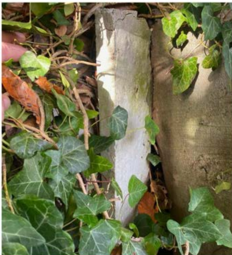
De gebroken pilaar aan de rechterkant (vanuit gezien) van de constructie/keerwand.
