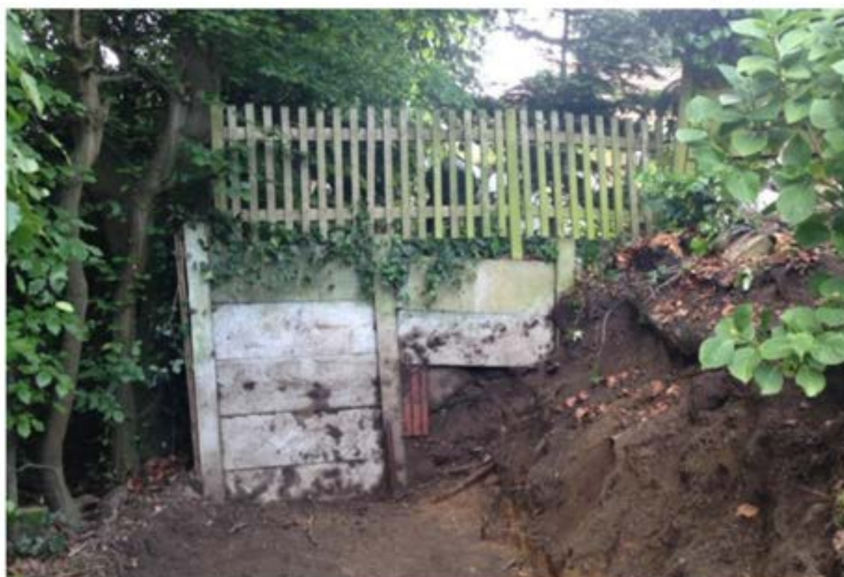
Achter [redacted] is te zien dat de keerwand met de buren van nummer [redacted] 25 cm verspringt.
