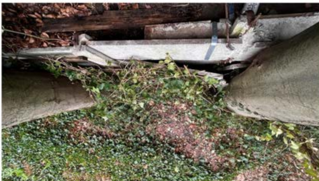
Keerwand uit kolom, nu vastgezet met beugel.
