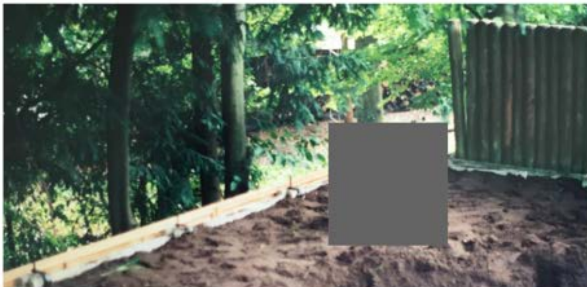
Achter [redacted] is te zien dat de keerwand met de buren van nummer [redacted], 25 cm verspringt.
