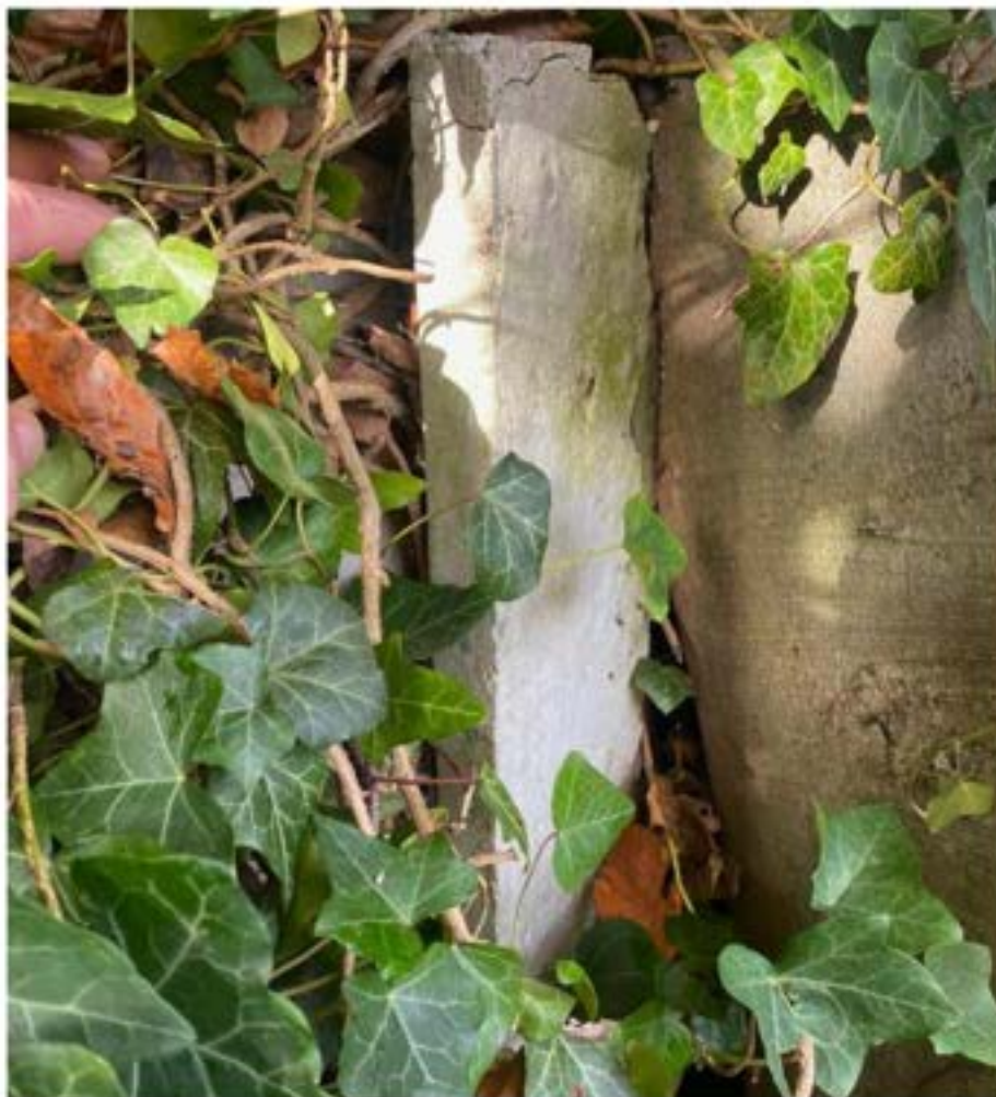
De gebroken pilaar aan de rechterkant (vanuit Kwant gezien) van de constructie/keerwand.
