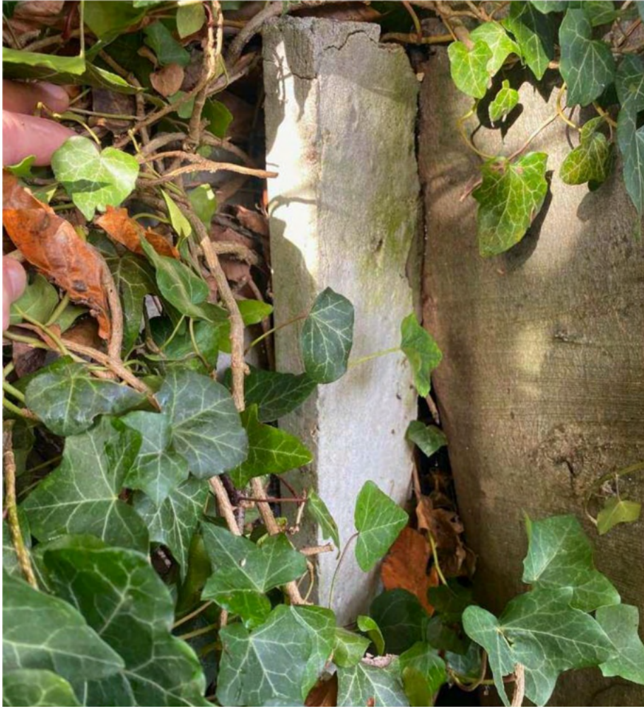
De gebroken pilaar aan de rechterkant (vanuit [redacted] gezien) van de constructie/keerwand.
