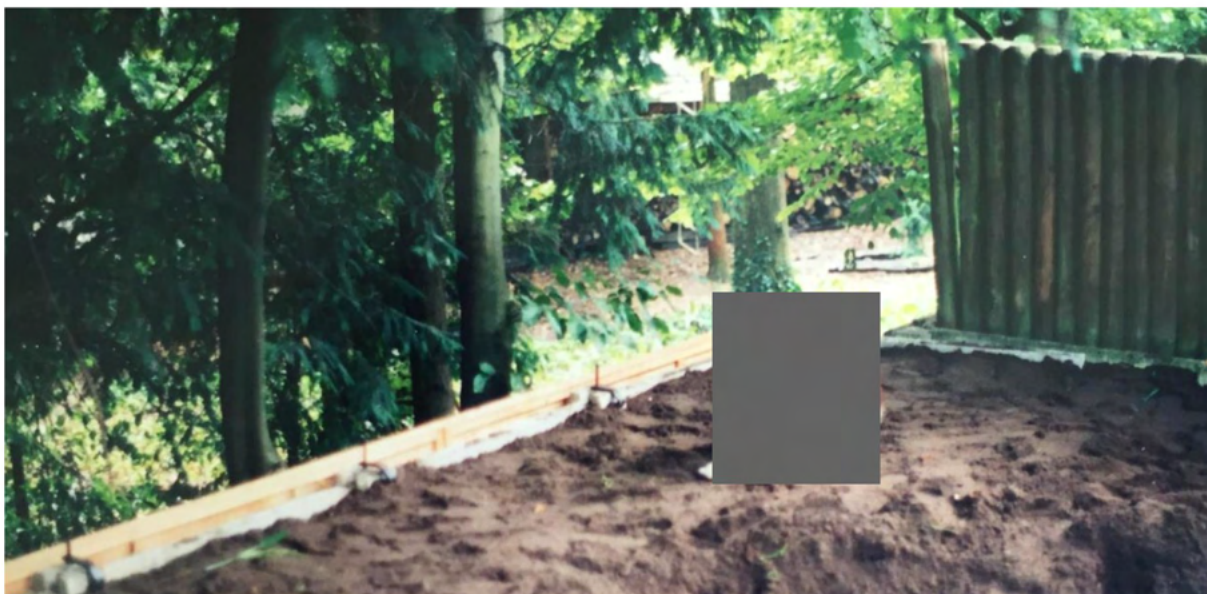
Achter de hond is te zien dat de keerwand met de buren van nummer 17, 25 cm verspringt.
