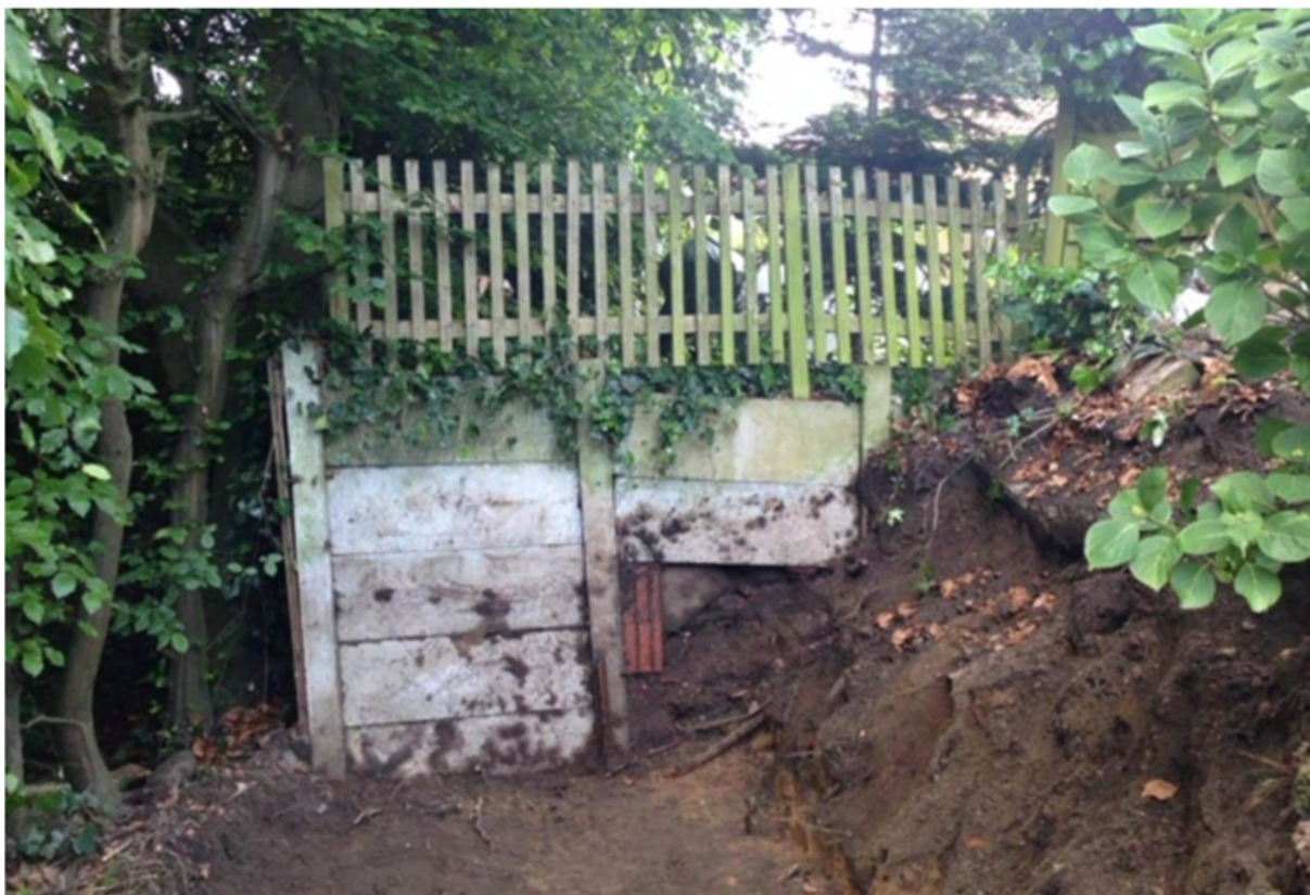
Achter de hond is te zien dat de keerwand met de buren van nummer 17, 25 cm verspringt.
