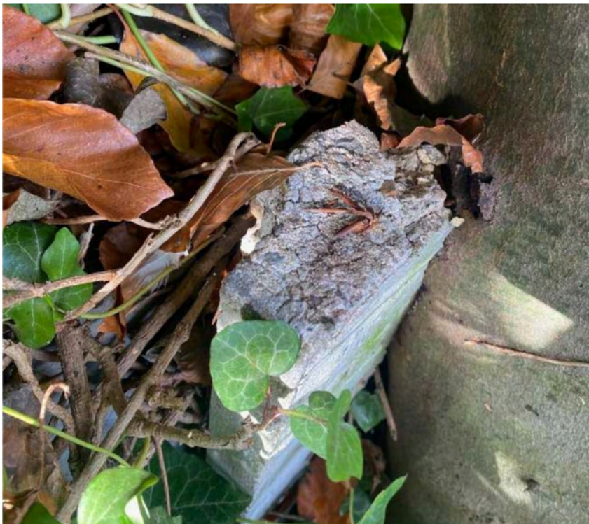
De gebroken pilaar aan de rechterkant (vanuit [redacted] gezien) van de constructie/keerwand.
