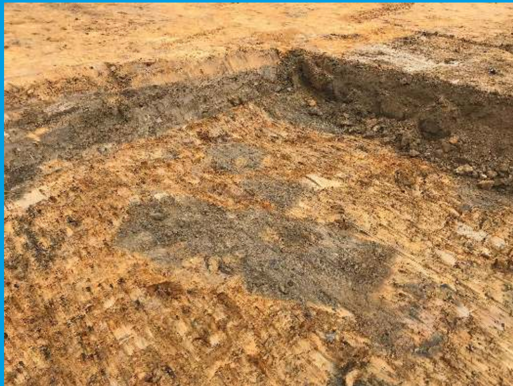
Saneringsput van eerder foutief aangebracht immobilisaat
