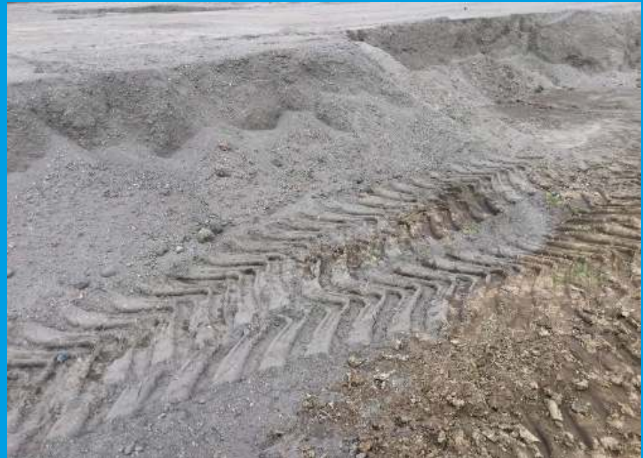
Immobilisaat is niet afdoende verdicht en vermengd met de bodem
