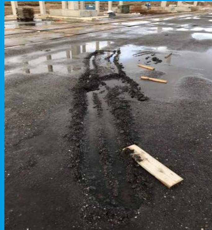
Beschadigd immobilisaat door bouwactiviteiten
