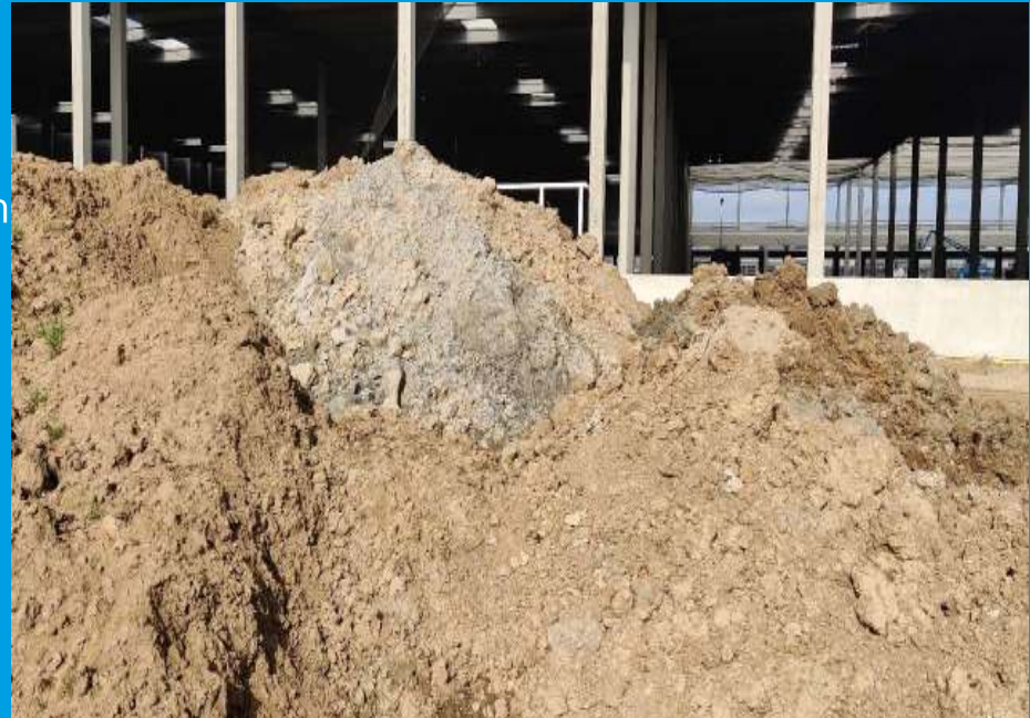
Illegaal samenvoegen (afval met grond)
