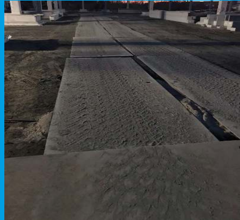
Stofvorming op rijplaten door aanwezige fijne fractie van niet verhard immobilisaat
