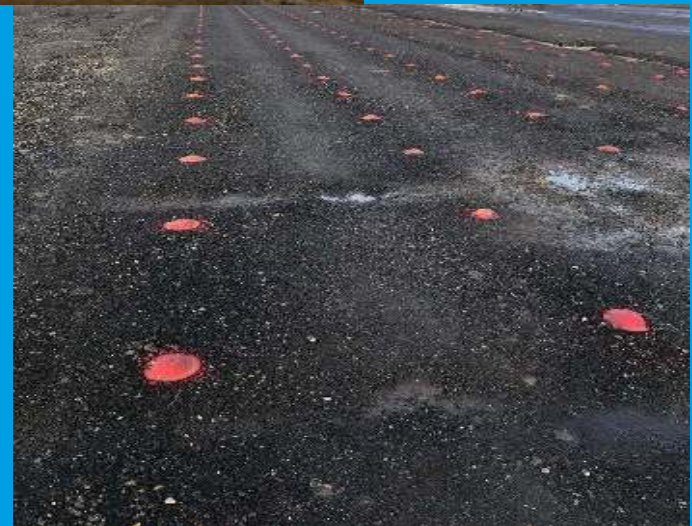
Heien door immobilisaat ten behoeve van draagconstructie
