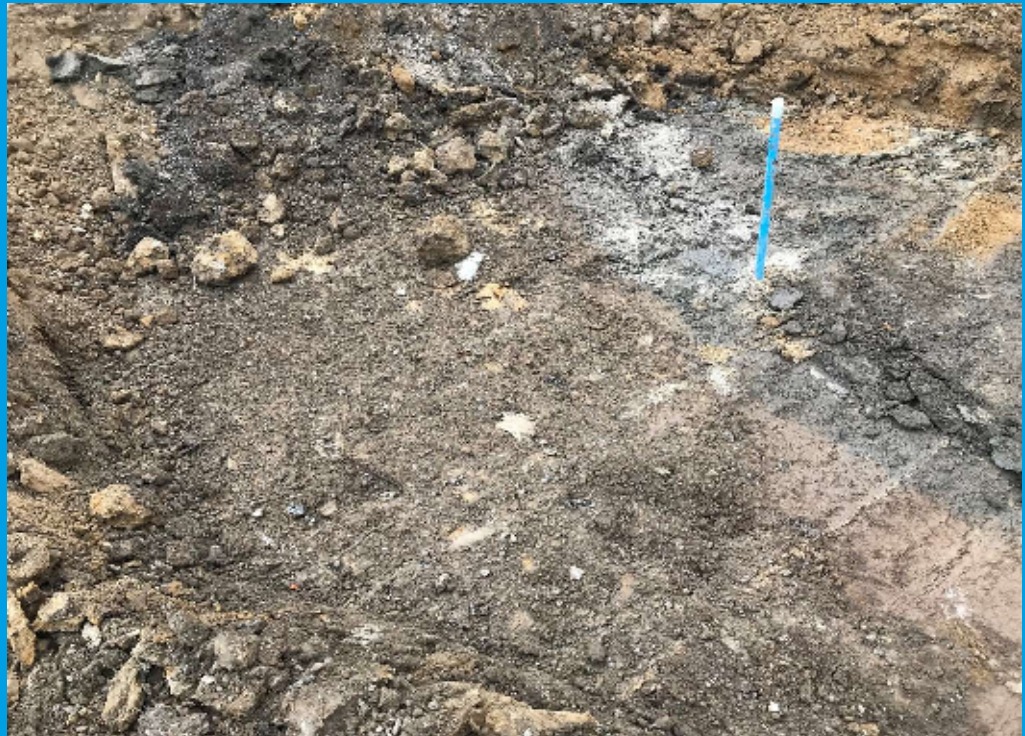
Saneringsput van eerder foutief aangebracht immobilisaat
