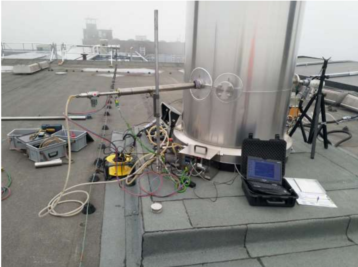
Foto 1c: Meetvlak van de biomassa stookinstallatie bij Veolia te Arnhem.
