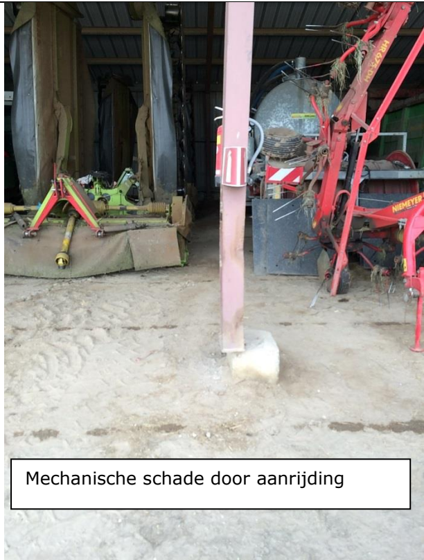
Omvalgevaar door zijdelingse belasting en slechte fundatie
