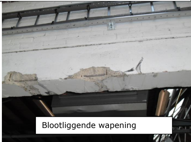
Vergeten aan te werken met beton
